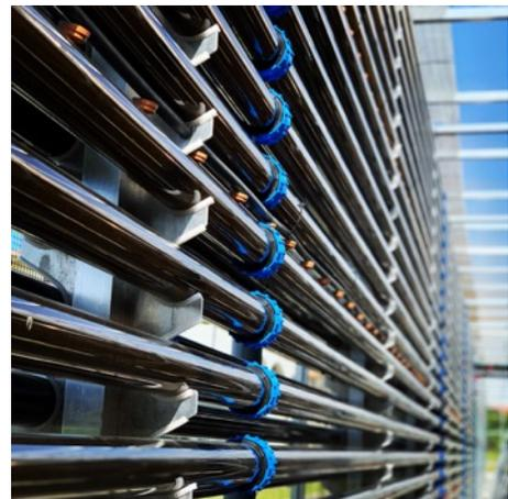
ガラスチューブ外径：65mm、チューブ総延長：約5km
